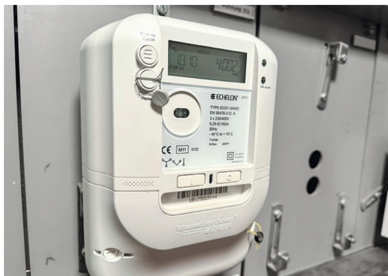
Smart Meter messen den Strom nicht nur, sondern übermitteln die Daten in Echtzeit an den Netzbetreiber. (Foto: AKT AG)
